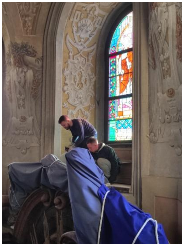
Іл. 3. Обгортання захисними матеріалами верхів'я головного вівтаря Гарнізонного храму (зліва на право: Арсен Шпак, Станіслав Волощенко).
