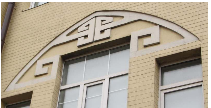
Фото 6. Прибутковий будинок (вул. І. Мазепи 18/29). Фрагмент декору. Світлина автора.
