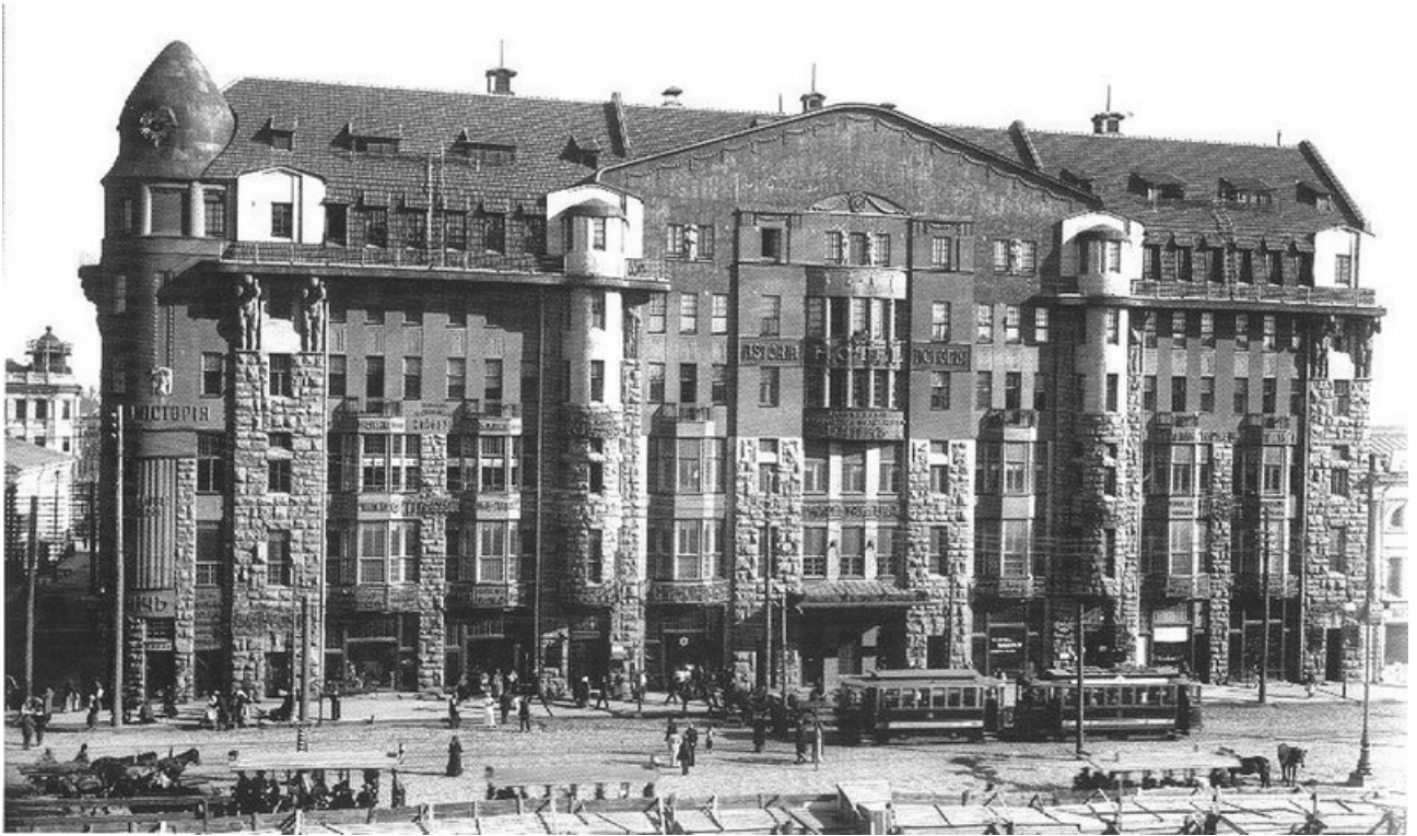
Фото 12. Будівля Купецького банку і готель «Асторія» (Харків, Павлівка пл., 10)
